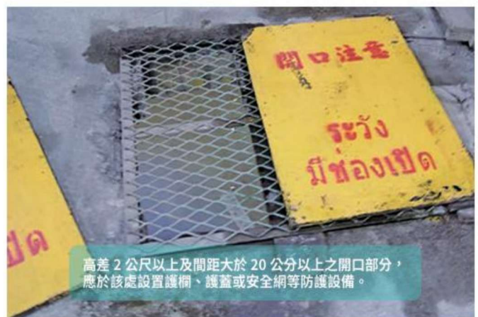
圖 13 地面開口設置護蓋及隔柵
