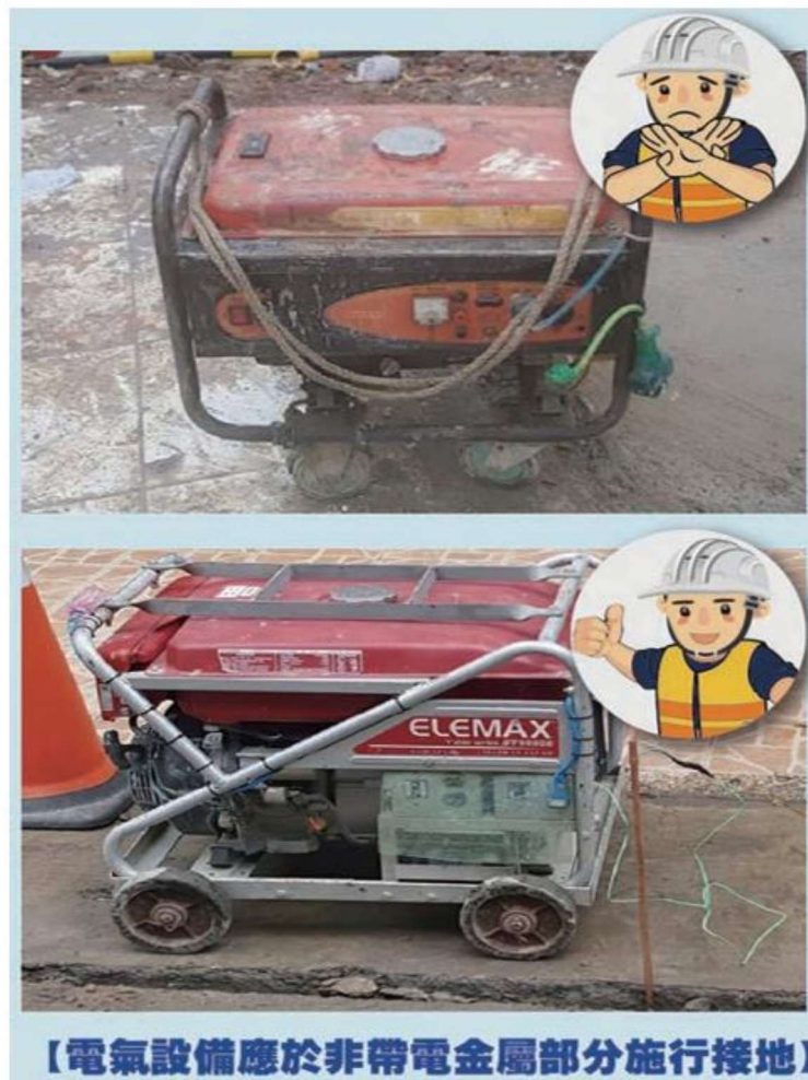
圖 25 電氣設備應於非帶電金屬部分實施接地
