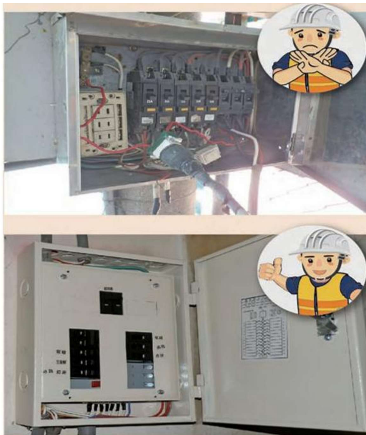
圖 27 配(分)電箱設置箱、蓋、中隔板參考例
