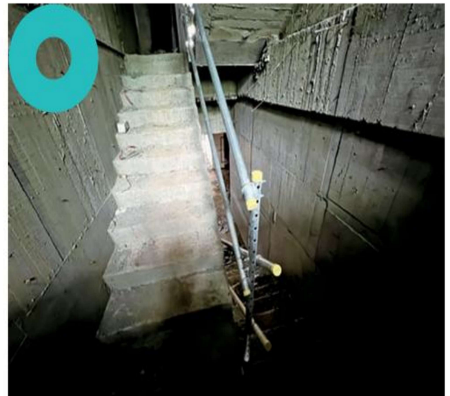
圖 20 構造物樓梯已設護欄 (可再加立柱及增設垂直安全網)
