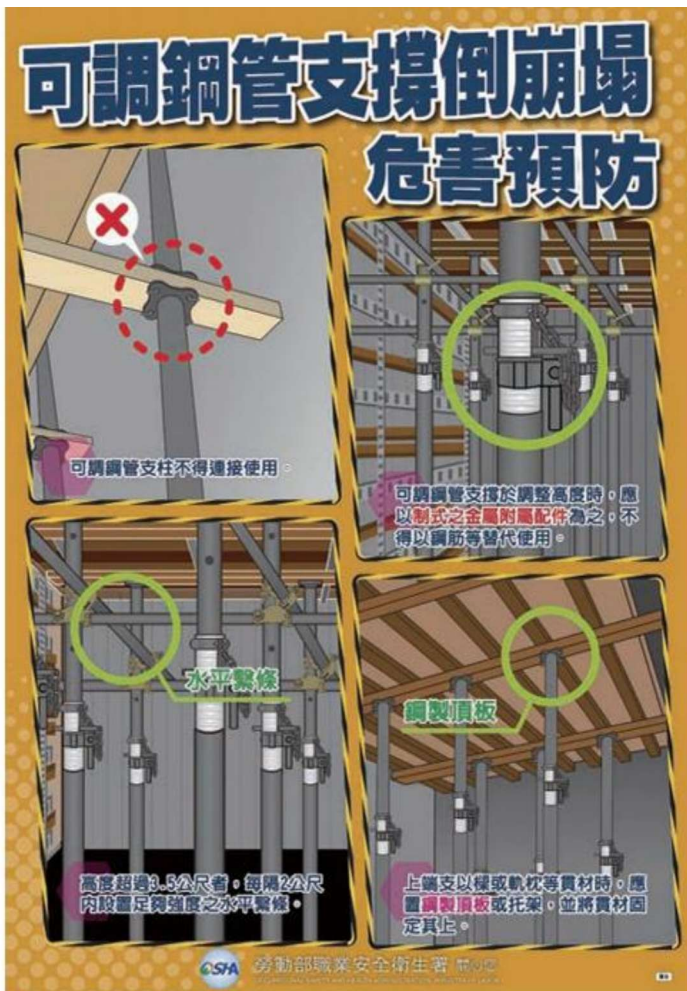
圖 35 可調鋼管支撐倒崩塌危害預防
