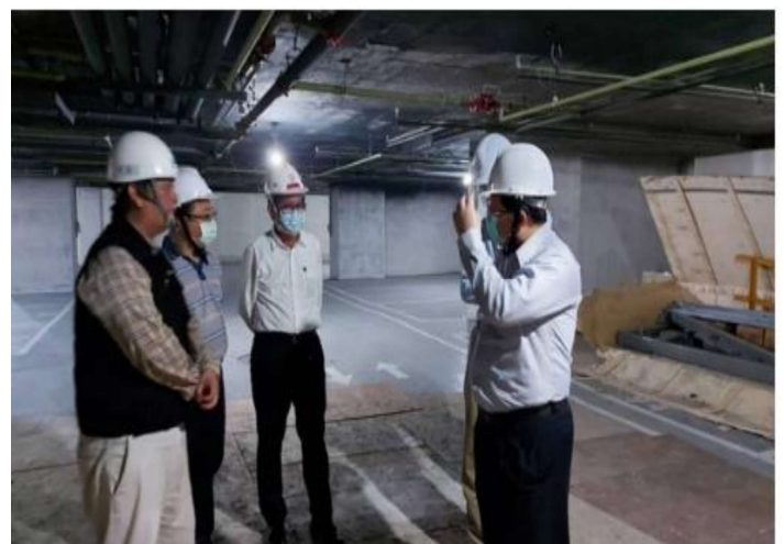
高市苓雅區一工地傳工安事故，一名工人墜電梯井傷重死亡，工務局到場了解，工務局提供
