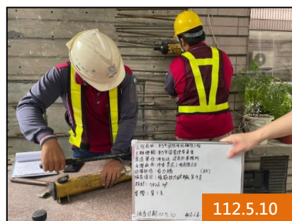
植筋拉拔試驗
