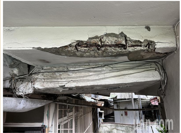
圖44 旋轉樓梯結構破損
