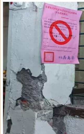
圖45 柱鋼筋裸露、混凝土剝落
