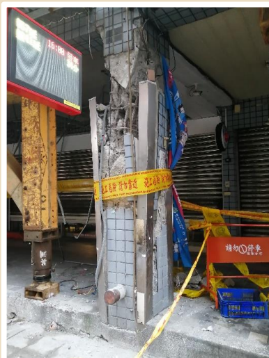
圖48 柱水泥塊崩落
