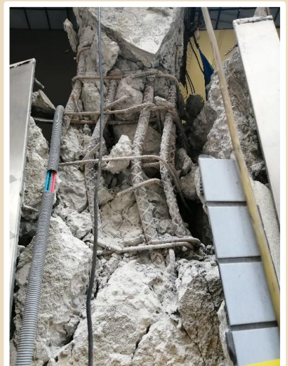
圖49 鋼筋變形
