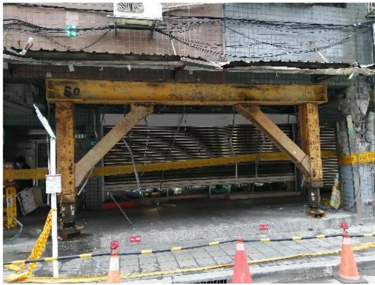
圖47 震後門型鋼構架臨時補強
