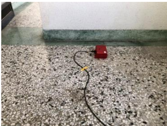
c. 3樓感測器配置照片
