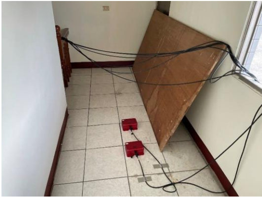
c. 6樓感測器配置照片
