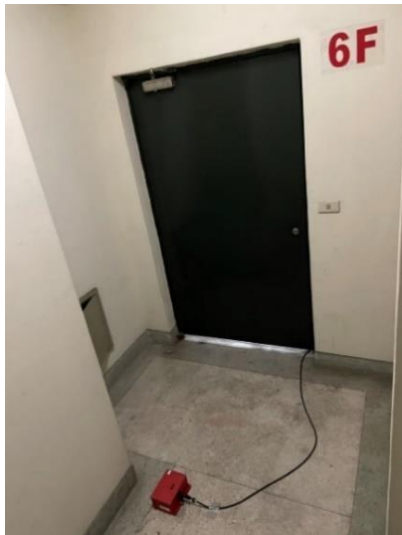
c. 6樓感測器配置照片
