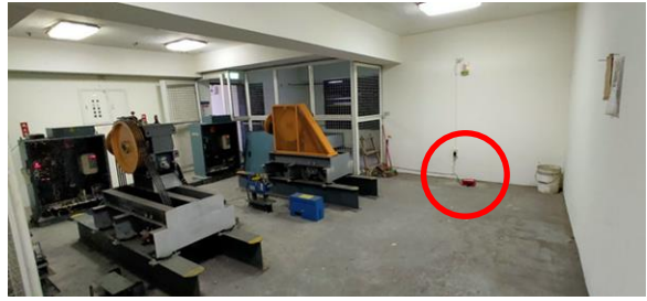
d. 頂樓強震儀配置照片
