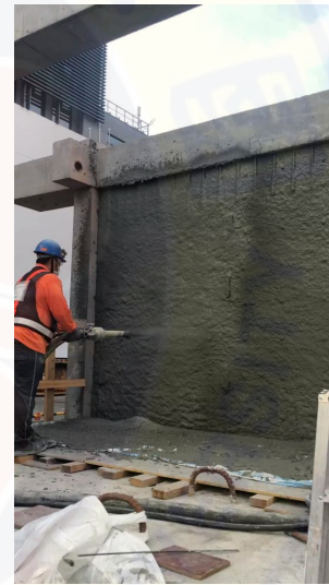
UHPC噴漿補強施工
