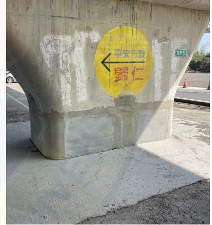
UHPC包覆補強
