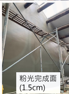
UHPC手鏟施工 (單面4cm)
