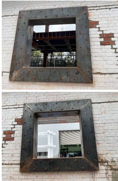
鋼框補強植入化學錨栓及焊接施作完成
