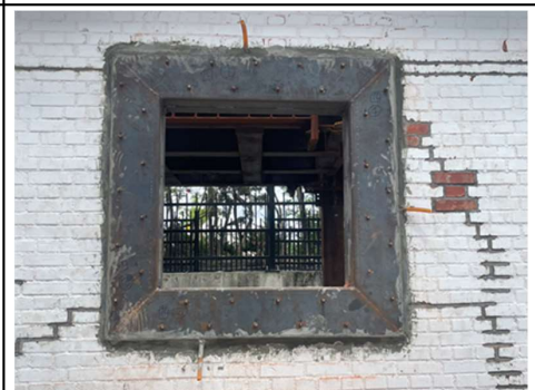
19.預埋無收縮水泥砂漿溢流、注入 管
