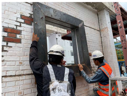
11.將補強鋼框移入
