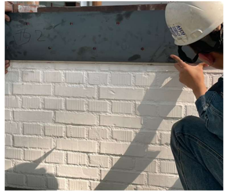
3. 標記預鑽孔位於磚牆牆面
