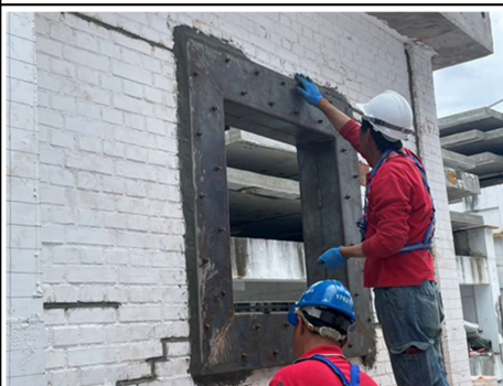
18.鋼板與磚牆牆面與開孔週邊空隙 填塞封填水泥
