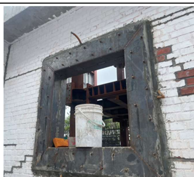
24.確認無收縮水泥砂漿由溢流管流出
