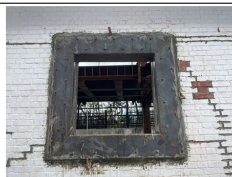
25.補強施工完成->26.鎖固
