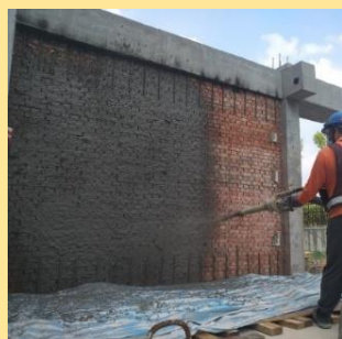
(a) UHPC噴漿施工
