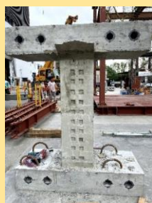
(g)敲除多餘混凝土
