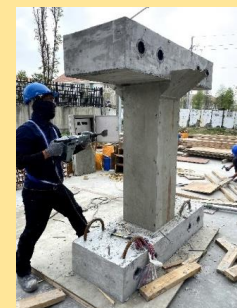
(f)敲除混凝土
