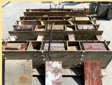
(d)預鑄版封模澆置UHPC
