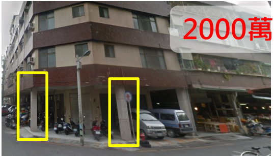
補強後(地震後)
