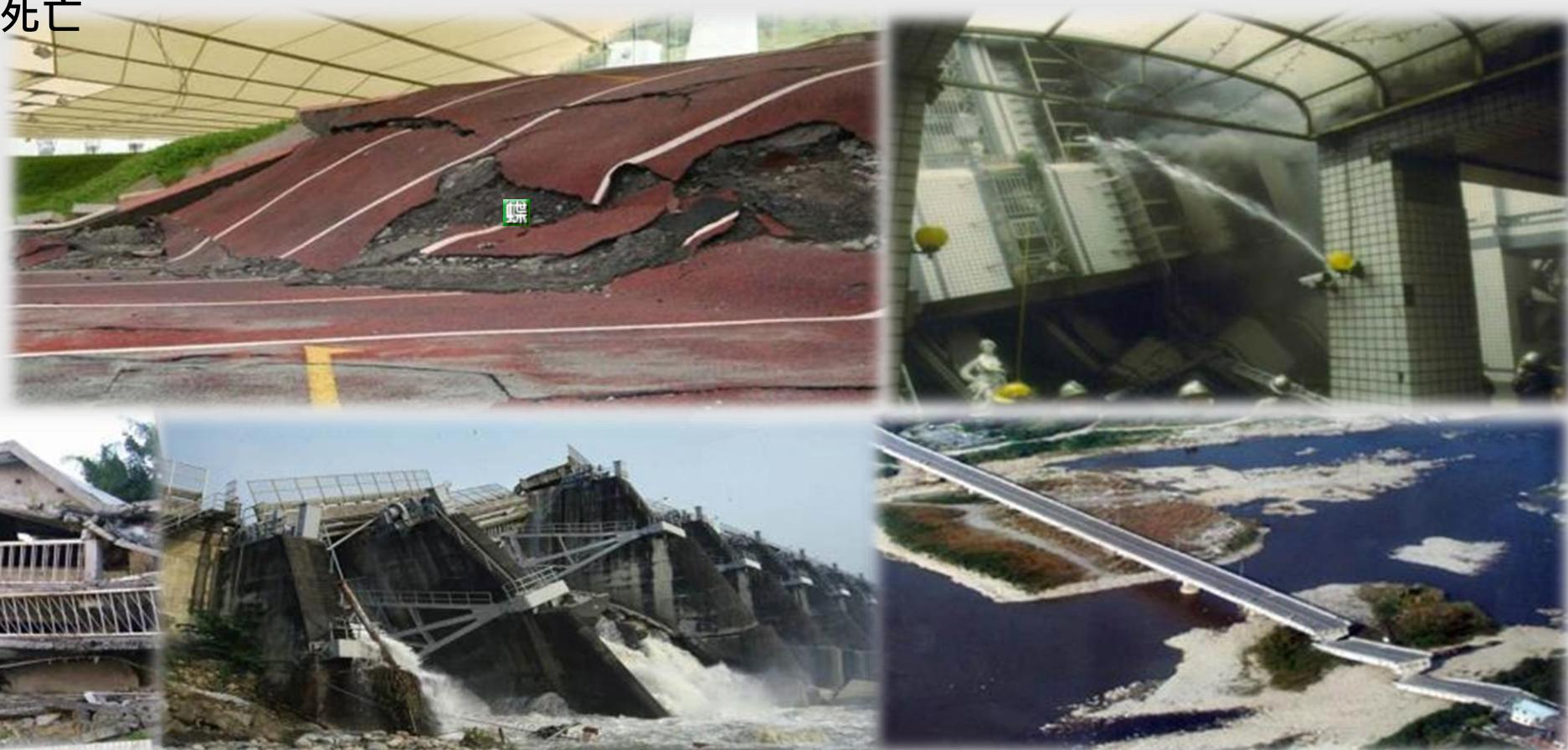
臺中光復國中校舍倒榻、新莊博士的家倒榻 + 火災、烏溪橋斷、石岡壩潰堤、操場隆起
