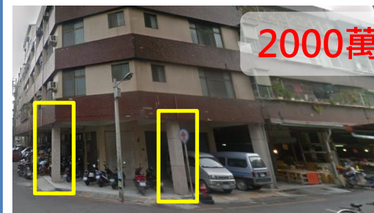
補強後(地震後)
