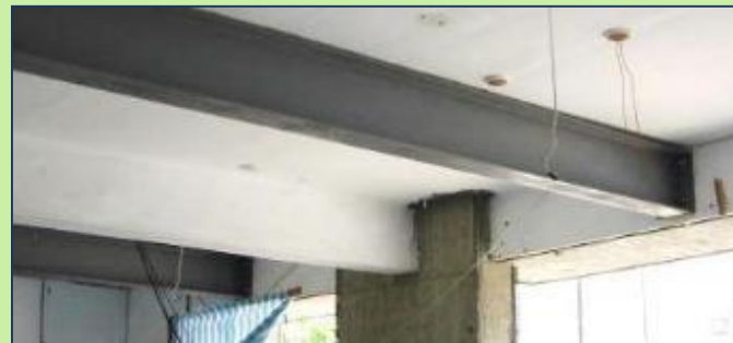
鋼結構補強
