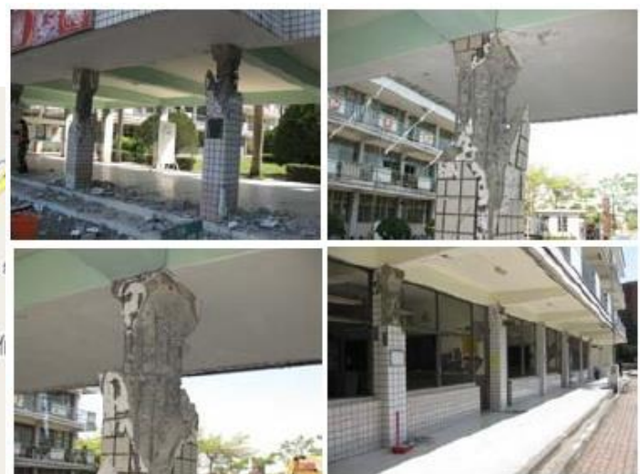
多處柱產生結構性損壞 影響結構整體耐震能力
