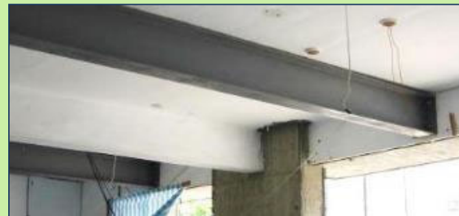
鋼結構補強
