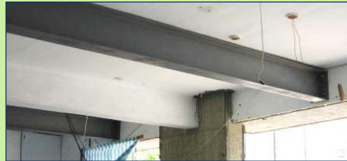
鋼結構補強
