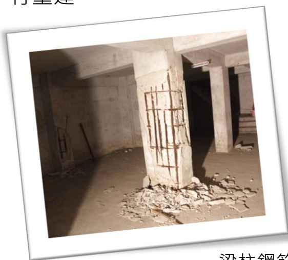
梁柱鋼筋鏽蝕、混凝土剝落
