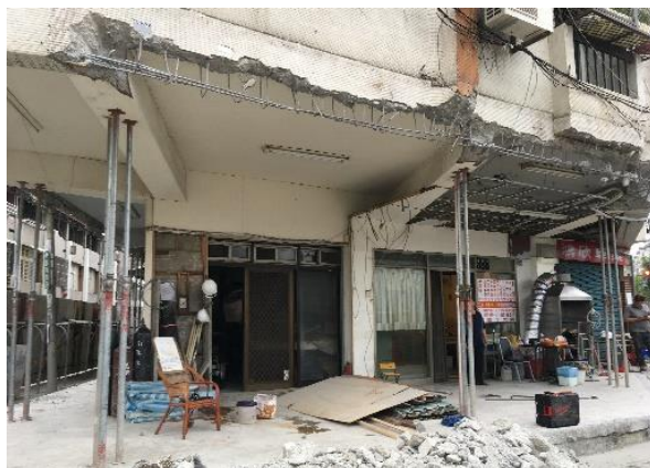
拆除、打除、臨時支撐
