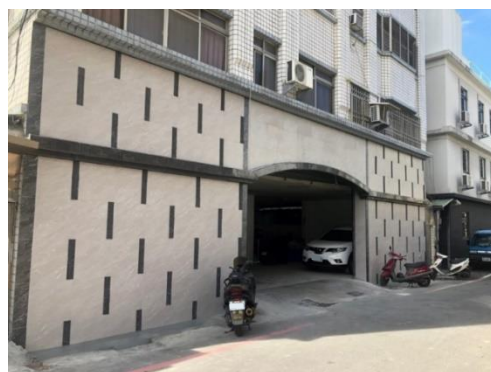
剪力牆補強後
