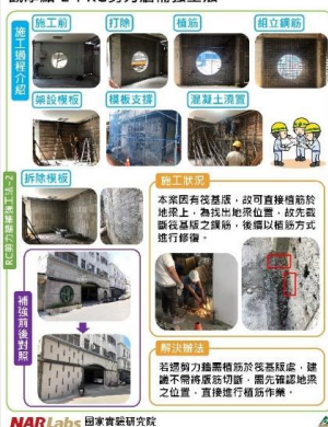
觀摩點 2：RC剪力牆補強工法 / 講員：楊智斌技師
