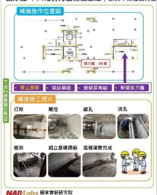
觀摩點 4：RC剪力牆補強工法 / 講員：涂耀賢博士
